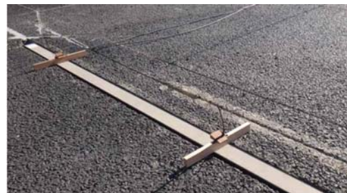
Instalación de corta duración , tan solo 8 horas por carril, poco invasiva.
